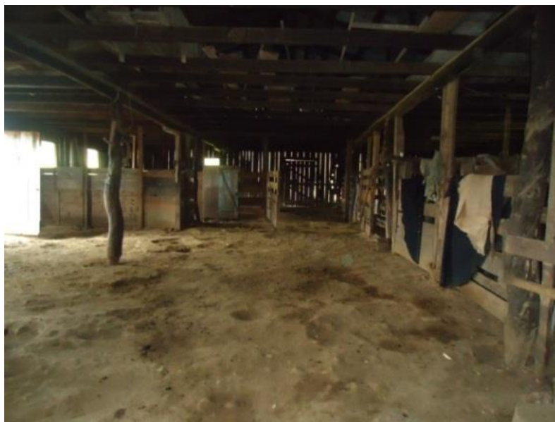
Figura 23 – Galpão de chão batido
