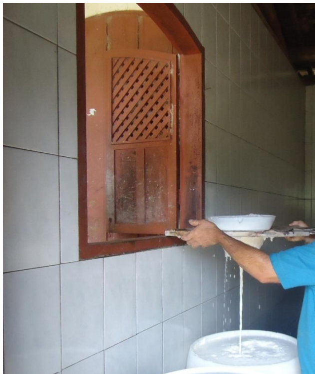
Figura 10 – Detalhe da janela para transferência do leite da sala de ordenha para o quarto de queijo
